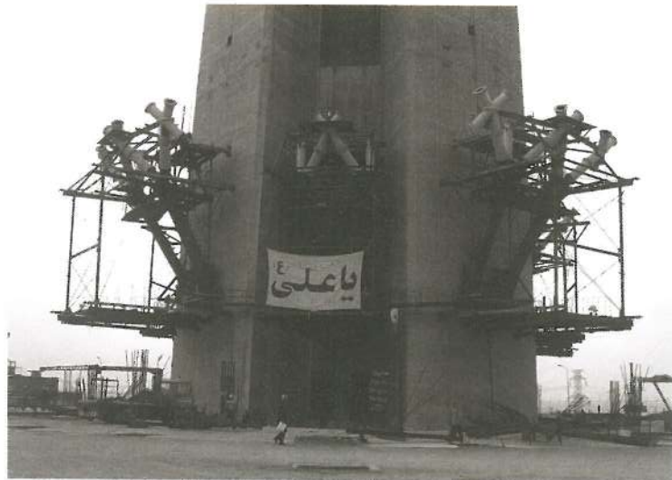
شکل-۷ آغاز بالابری ۲ STAGE سازه رأس برج میلاد
