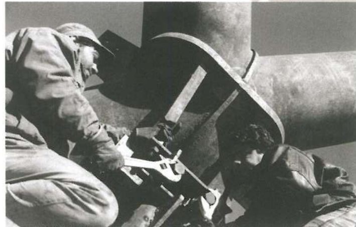
شکل ۵- مکانیزم تنظیمی فضایی گره های سبد با توجه به درجات آزادی مختلف
