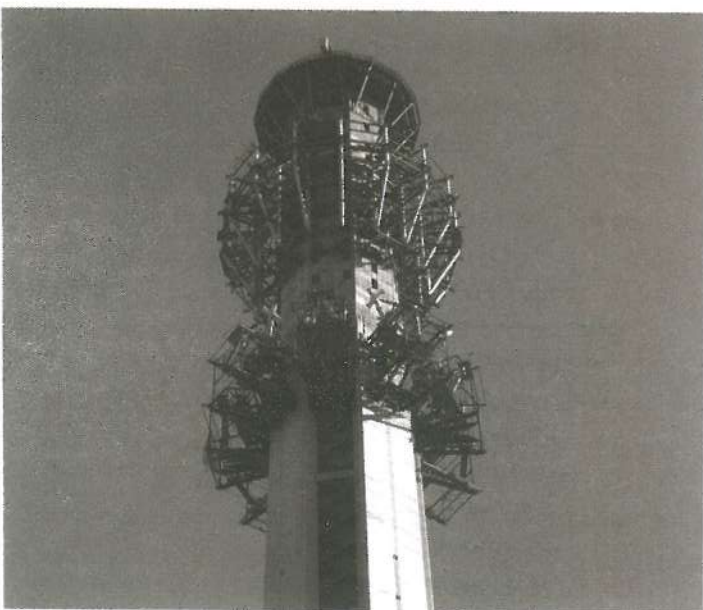
شکل-۸ سازه ۲ STAGE در نزدیکی تراز نصب
