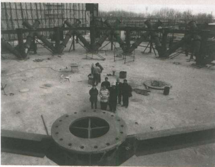
شکل ۴- کارگاه پیش مونتاژ ۲ Stage سازه رأس برج میلاد
